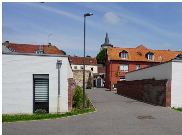
Aperçu du béguinage neuf à l'avant et des deux bâtiments réhabilités à l'arrière
