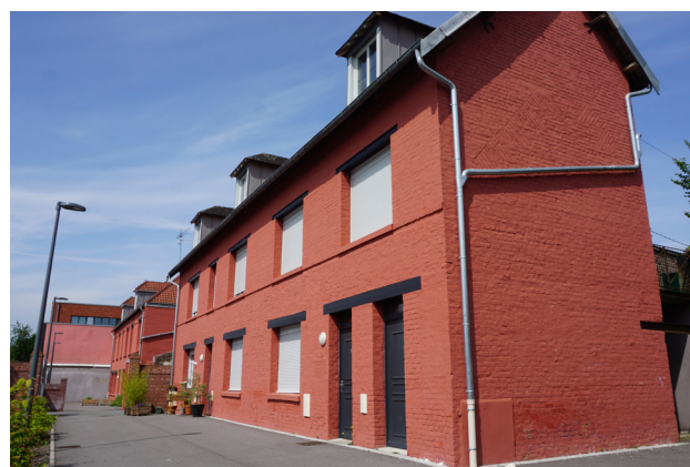
Les deux bâtiments réhabilités se trouvent côte à côte
